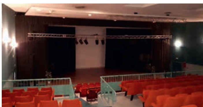
Pont sur treuil salle Voltaire
