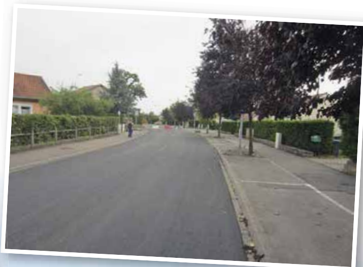
▲ Reprise du tapis boulevard de la Tournaille, mise aux normes PMR des traversées de chaussée, sécurisation croisement avec rue du Mont-Cassin avec des coussins berlinois et un marquage à la résine
