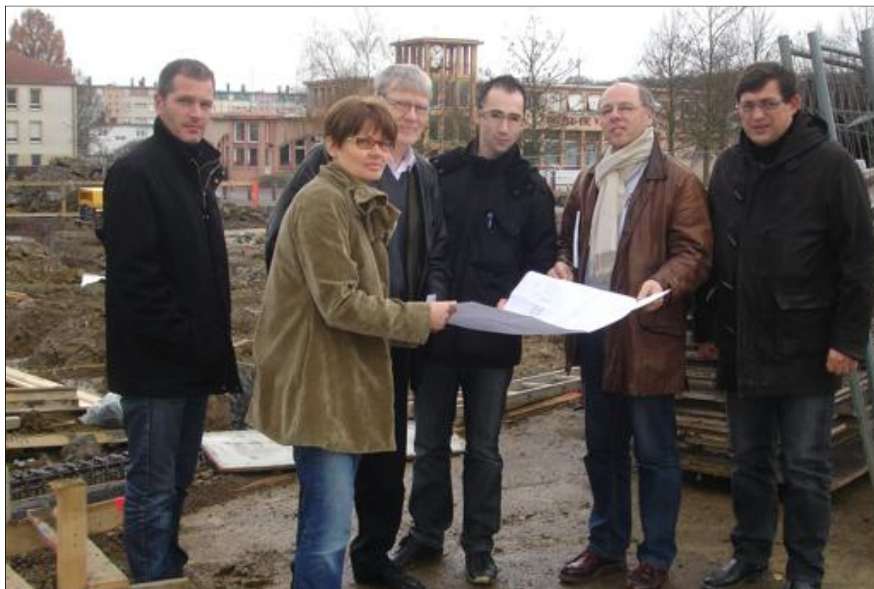
Une visite du chantier a lieu tous les jeudis matins pour faire le point. Photo RL
