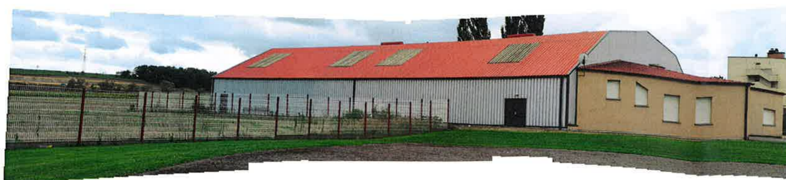
_PC6 vue 1 - site existant - façade est
