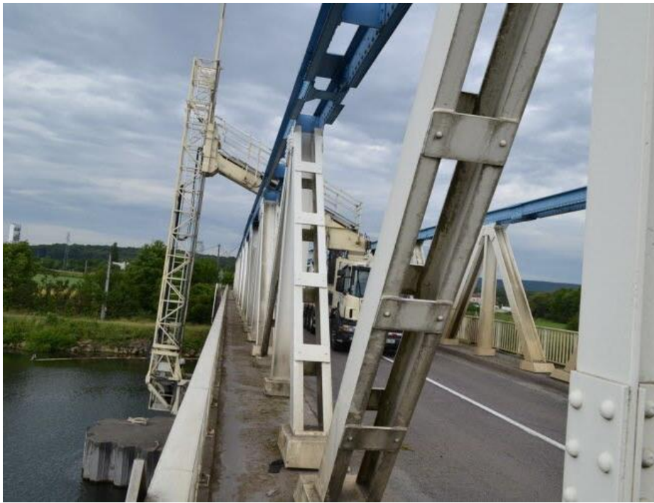
03 / 03 La passerelle est tournée sous le pont. Photo RL
