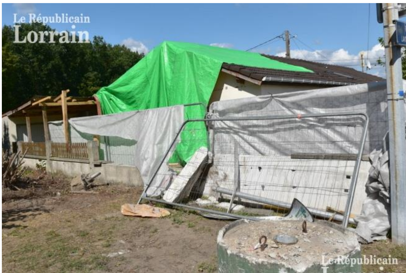
Photo HD Les dégâts liés à l'accident sont très importants. Photo RL
