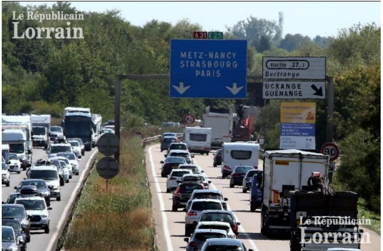
Photo HD La circulation est déjà dense sur l'A31 avant travaux. Photo Philippe NEU
