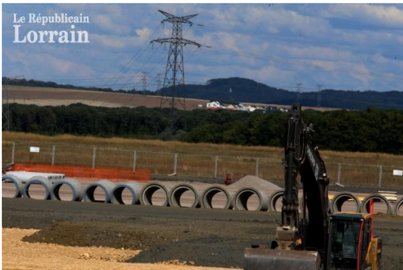
Photo HD Le projet d'installation d'une usine de laine de roche à Illange a été examiné par la mission régionale d'autorité environnementale. Photo Pierre HECKLER
