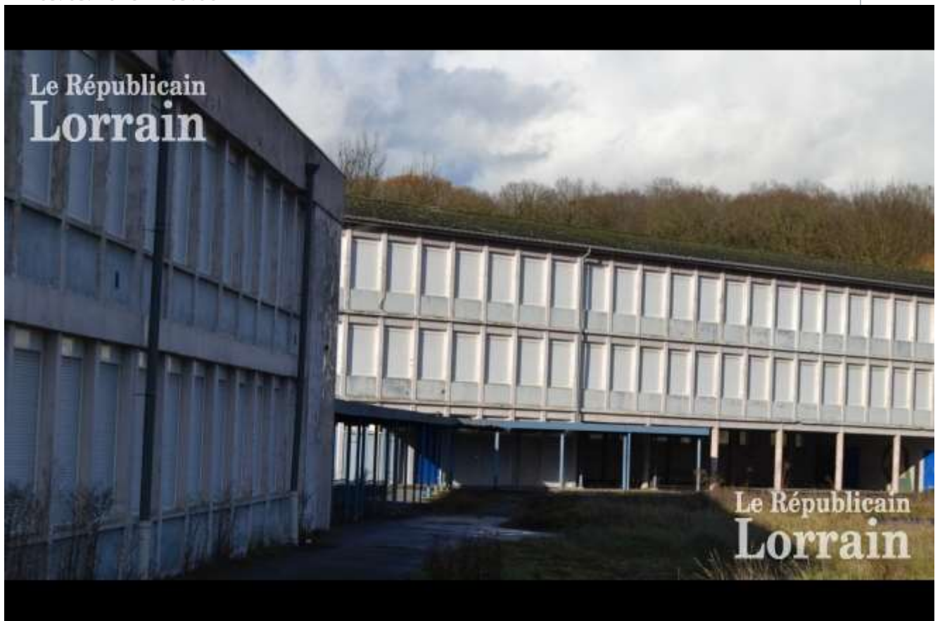
Photo HD Les immenses bâtiments de l'ancien lycée devraient enfin être réhabilités. Photo RL
