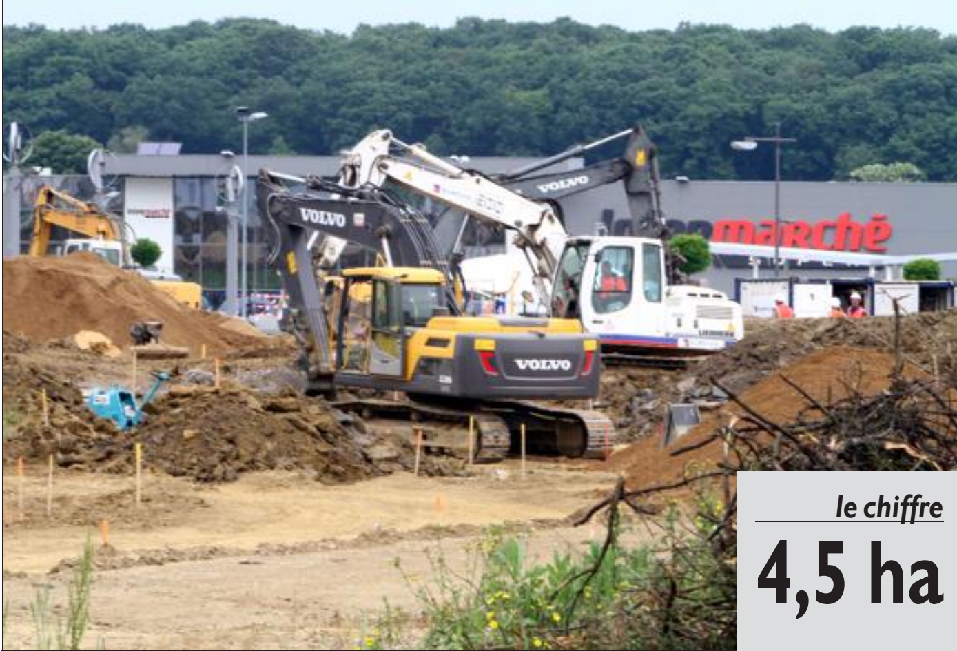
Le lotissement des Sentiers d'Hélios se situera en face de l'Intermarché de Guénange. Photo Philippe NEU.
