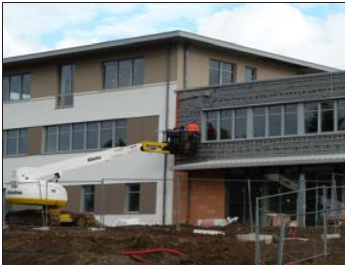
Les ouvriers dans les airs pour les façades. Photo RL
