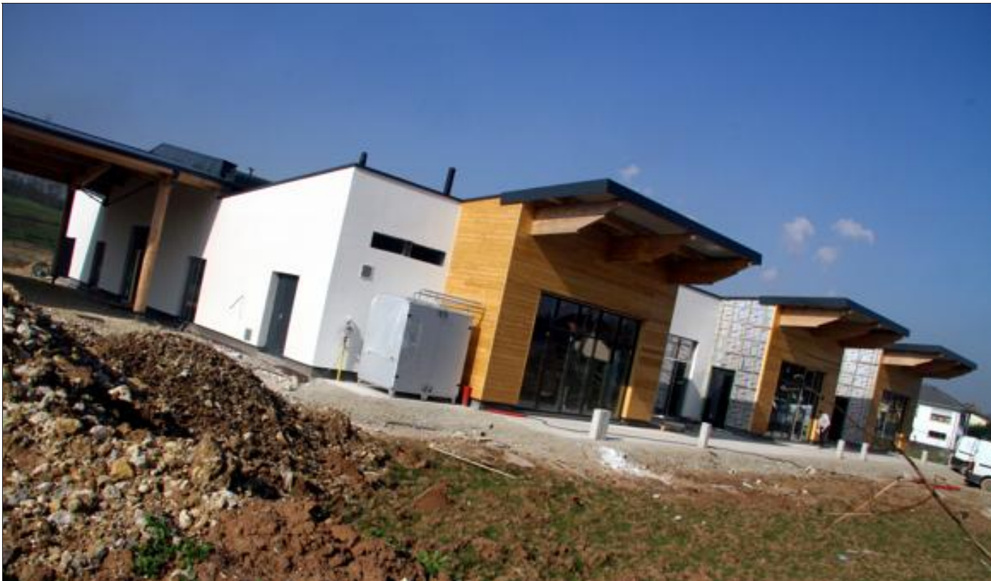
La maternelle de Kœnigsmacker est presque achevée. A l'intérieur, les entreprises s'activent pour les menuiseries, les peintures et l'aménagement des salles. Photo Philippe NEU.
