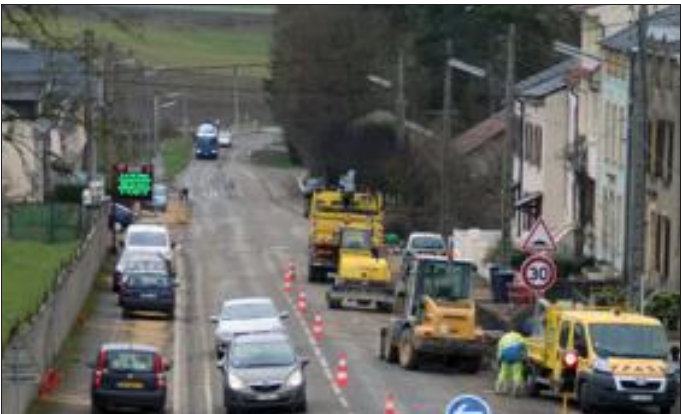
Le chantier de la rue du Parc, vu du pont SNCF. La circulation alternée ne sera bientôt plus qu'un mauvais souvenir. Photo RL
