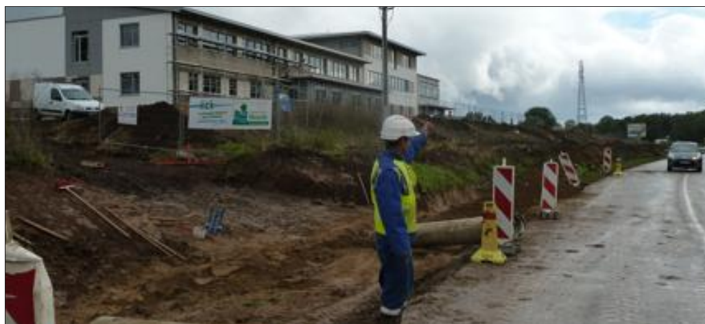
La piste cyclable qui longera la départementale engendre bien des désagréments.
