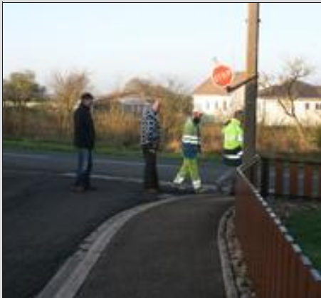
Élargir le trottoir pour le sécuriser pour l'accès à l'école
