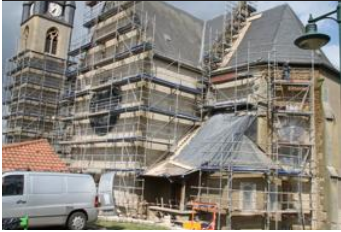
L'église Sainte-Catherine est entourée d'un imposant échafaudage pour les travaux de rénovation. Photo RL
