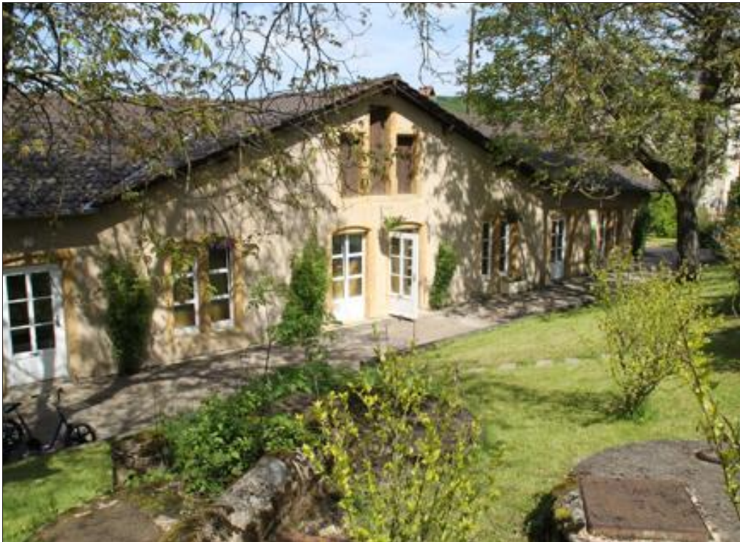
Le bâtiment A abrite l'administration, le bassin d'hydrothérapie et des salles spécialisées. Photo RL
