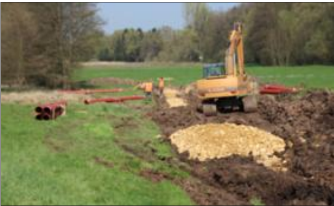
D'importants travaux de terrassement ont lieu en aval de la localité. Photo RL
