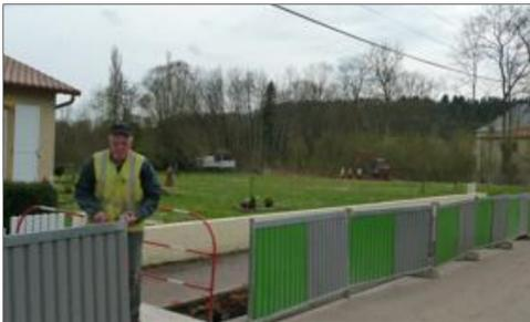
Les travaux entrepris par ERDF consistent à enterrer une partie du réseau aérien en 30 000 volts. Photo RL
