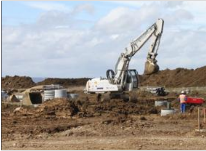
Les travaux du nouveau lotissement ont démarré début avril, les terrains vont bientôt être mis en vente. Photo RL
