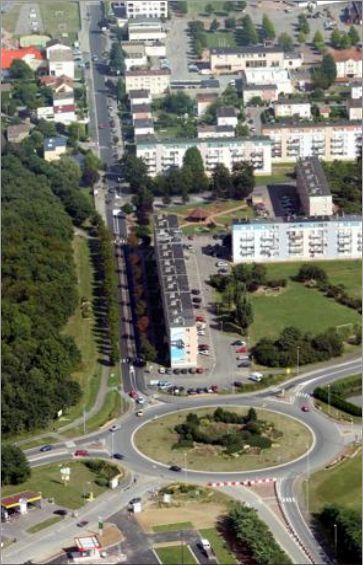
300 000 € seront consacrés à divers travaux de voirie dans l'ensemble de la commune. Photo Pierre HECKLER
