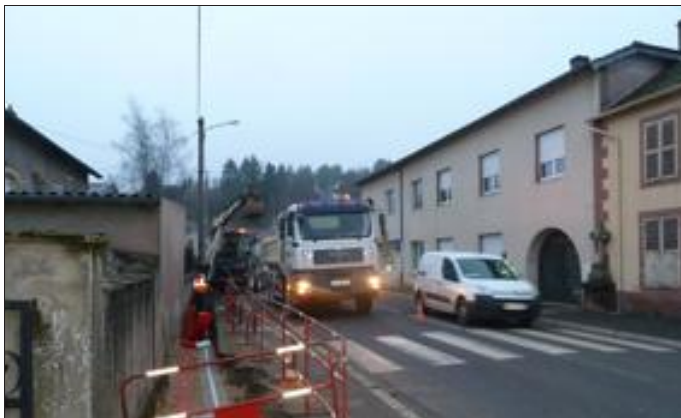
Circulation alternée ou rue barrée, prudence ! Photo RL
