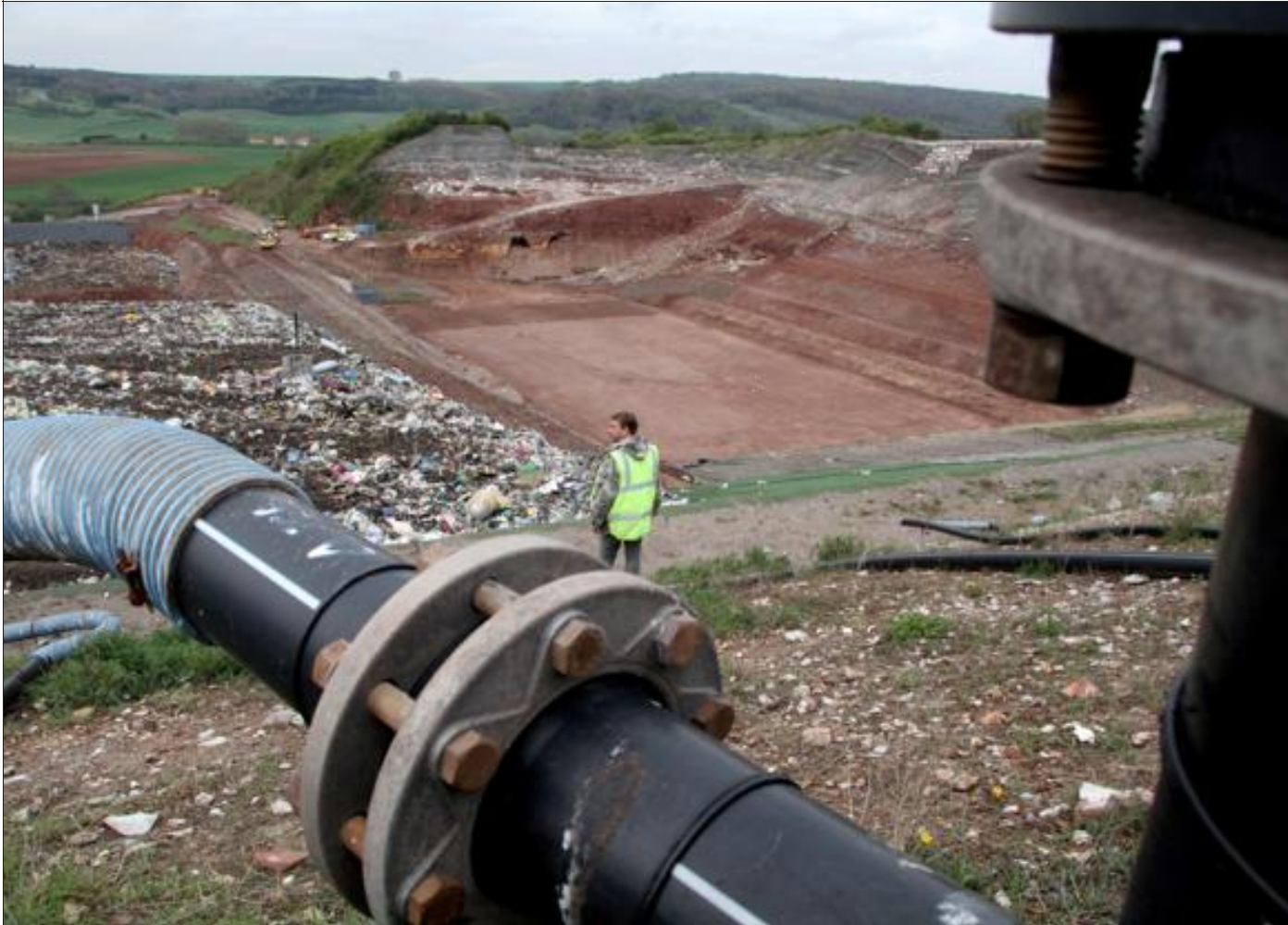
Jusqu’à présent, le biogaz émanant de la fermentation des déchets était éliminé en torchère. A l’avenir, il servira de combustible pour alimenter un moteur de production d’électricité.
