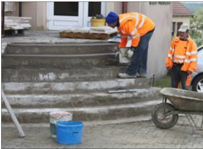
Les ouvriers ont restauré l'escalier de la salle polyvalente en deux jours. Photo RL
