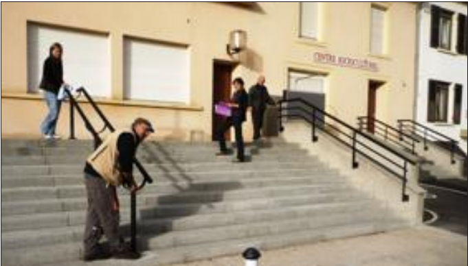
Les employés de la commune, testent les mains courantes qui viennent d'être installées sur le nouvel escalier. Photo RL
