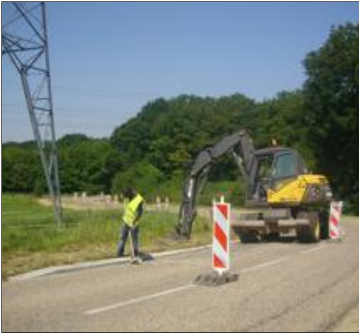
Les bas-côtés intérieurs des deux virages sont désormais stabilisés à l'entrée de Metzervisse. Photo RL
