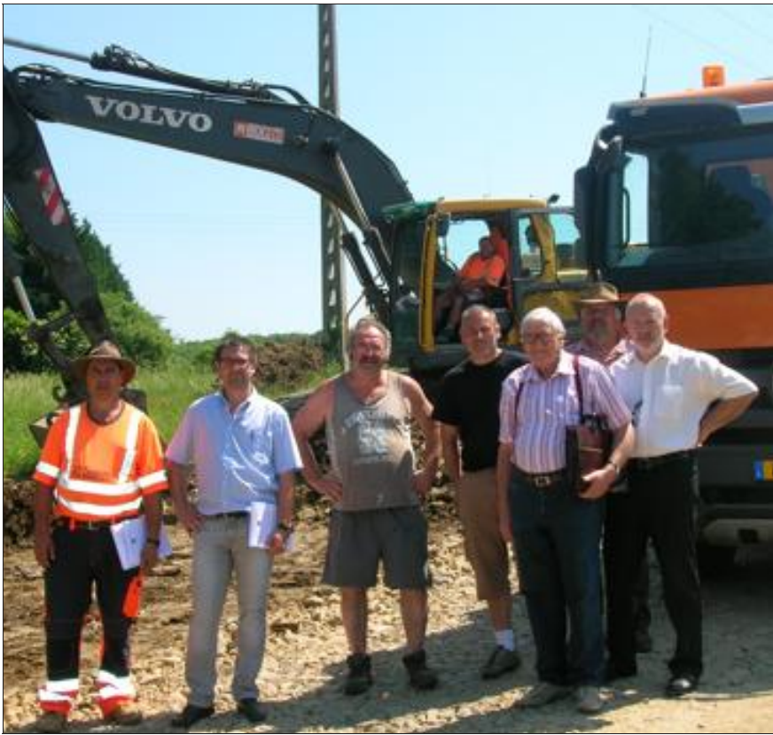
Les réunions de chantier permettent à la municipalité de bien suivre l'avancement des travaux du futur lotissement. Où l'on a opté pour un mode d'assainissement écologique. Photo RL
